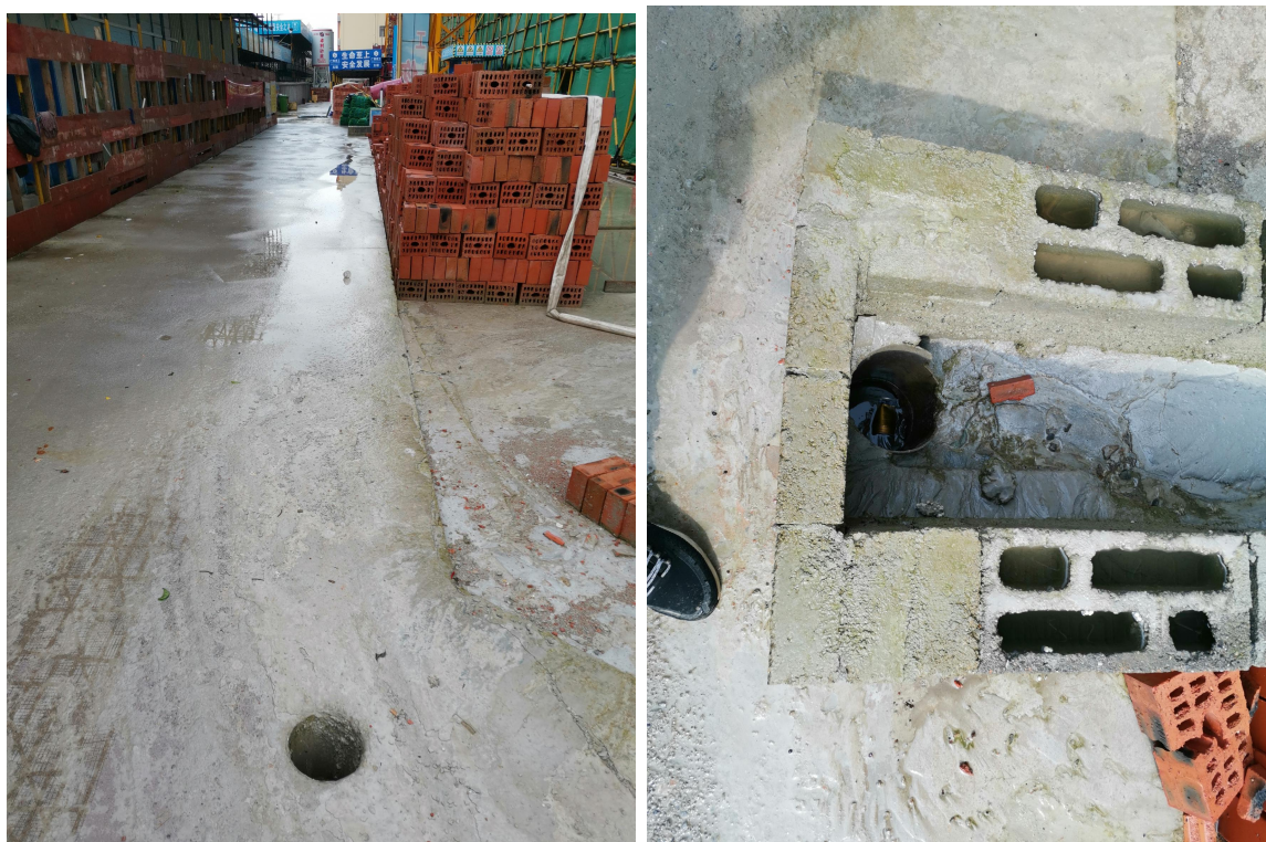
主体工程区已有埋地排水管入水口（根据项目进度已撤销）
