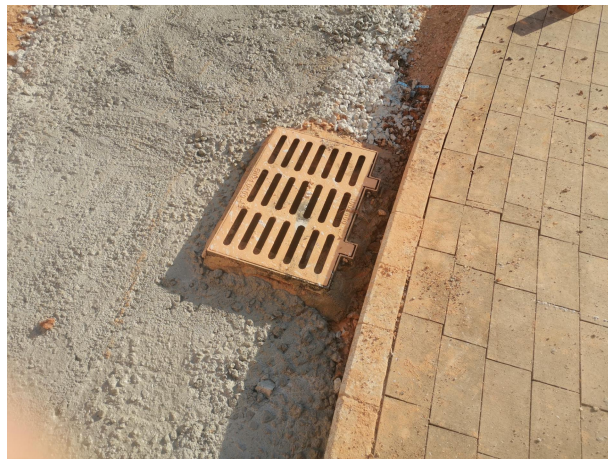
主体工程区已有综合绿化、盖板排水沟、雨水工程措施
