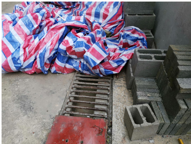
主体工程区已有临时排水沟、临时覆盖措施（根据项目进度已撤销）
