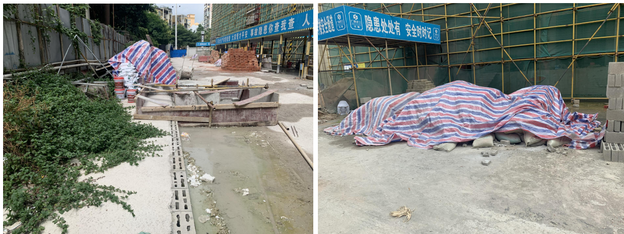
施工生产区彩条布覆盖措施（根据项目进度已撤销）
