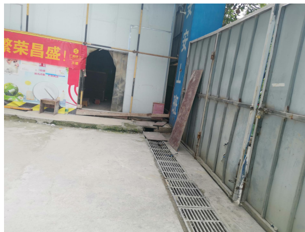
主体工程区已有临时排水沟及沉沙池措施（根据项目进度已撤销）
