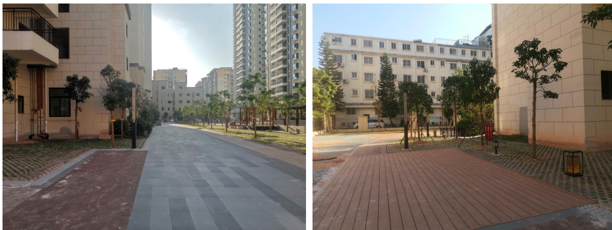
主体工程区已有综合绿化、透水铺装措施
