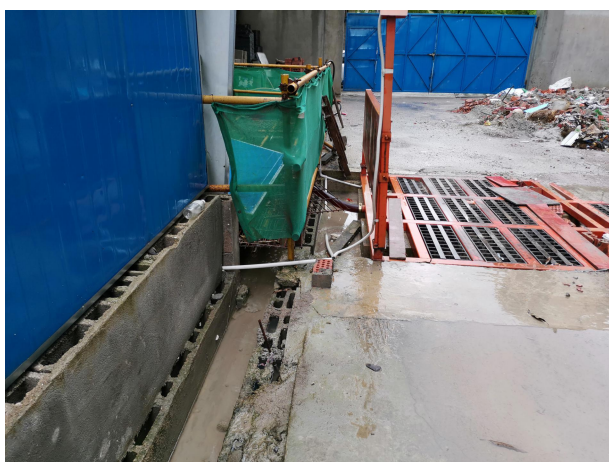
主体工程区已有临时排水沟及沉沙池措施（根据项目进度已撤销）
