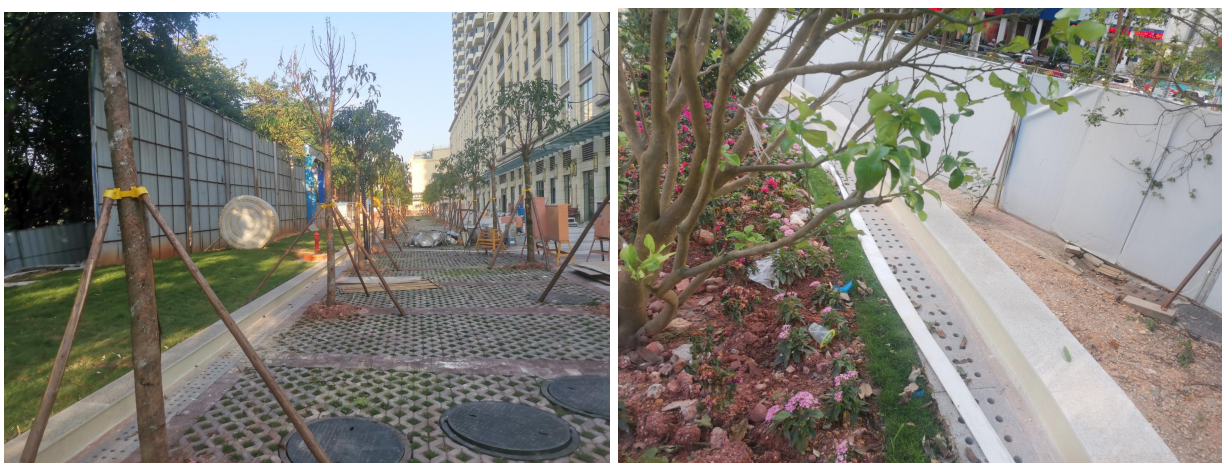
主体工程区已有综合绿化、盖板排水沟措施
