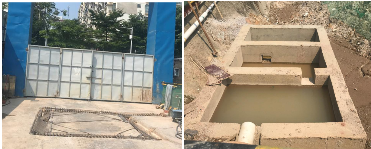
主体工程区已有洗车池及沉沙池措施（根据项目进度已撤销）
