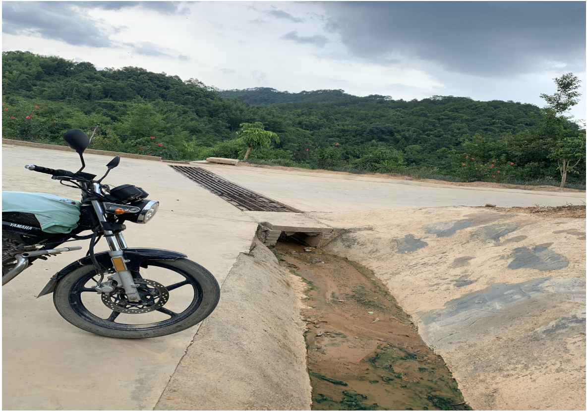
矿山道路区排水设施
