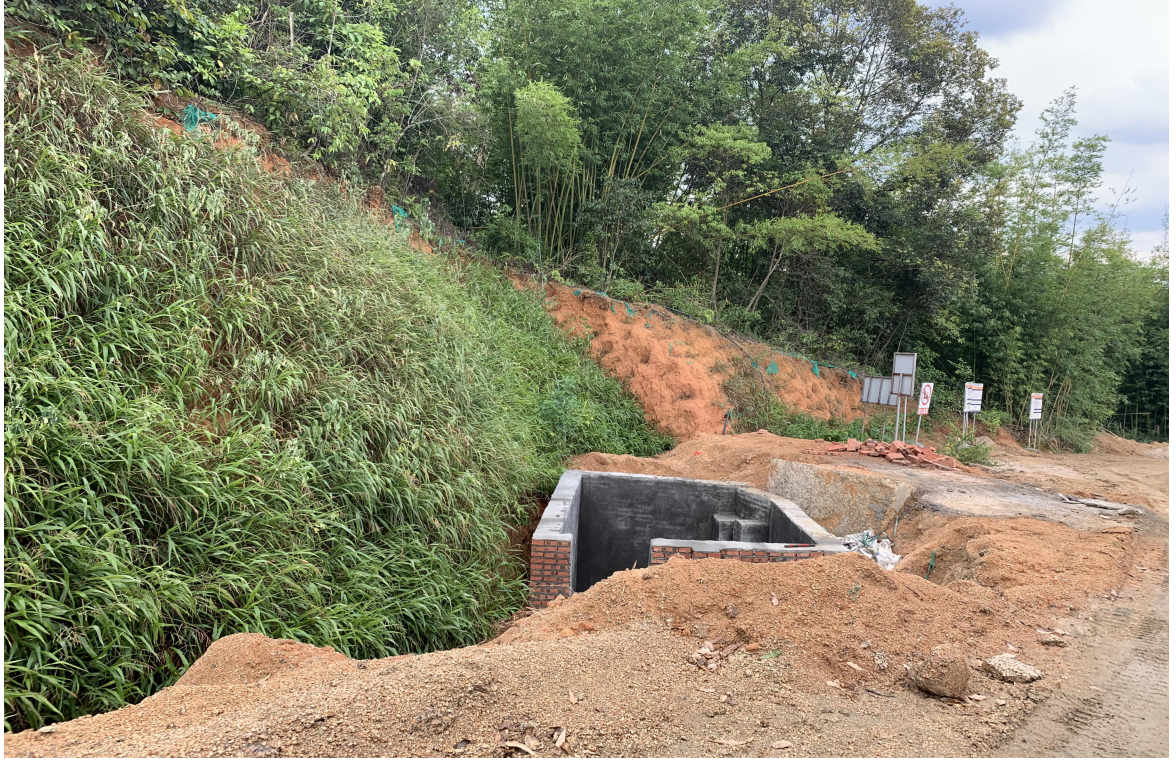
砖砌沉沙池现状
