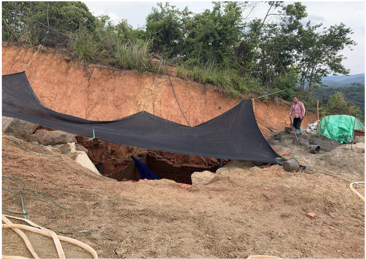
矿山道路区砖砌沉沙池
