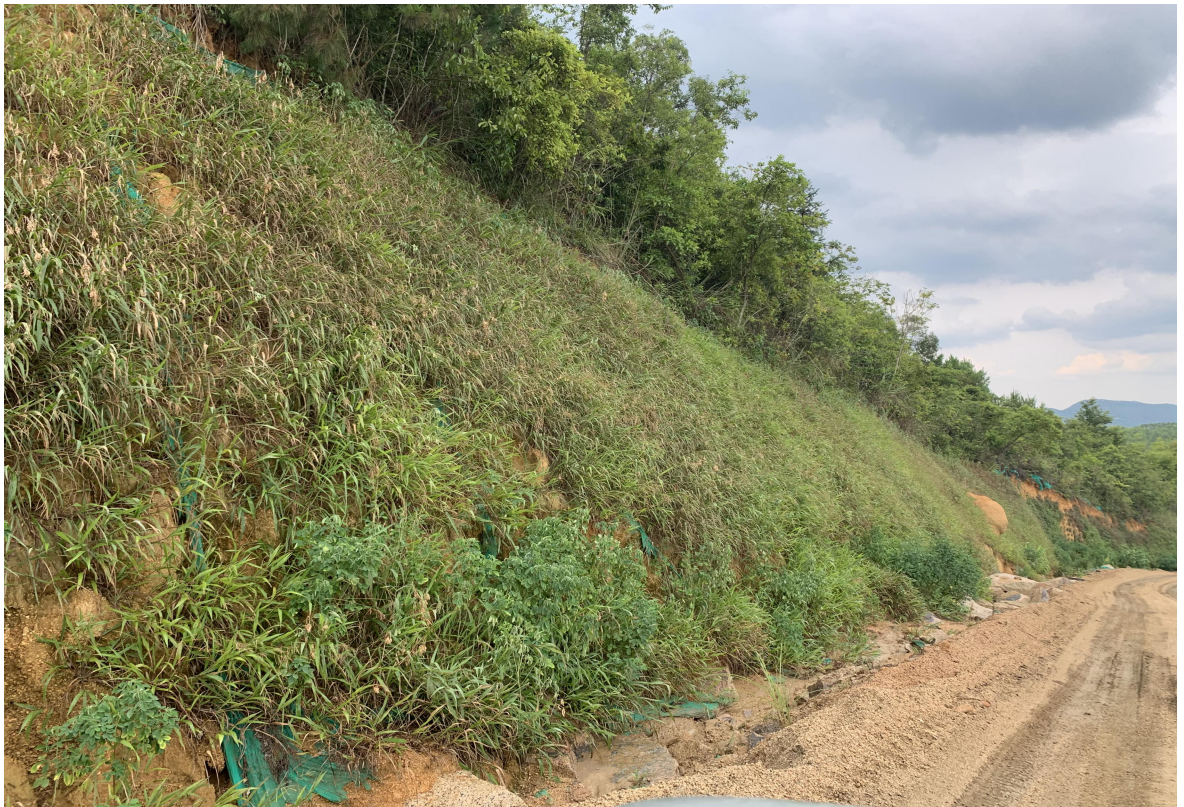
矿山道路区边坡现状
